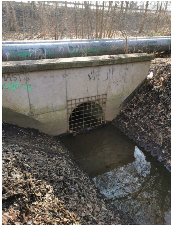
Krata na Potoku Szobiszowickim przy ul. Folwarcznej
