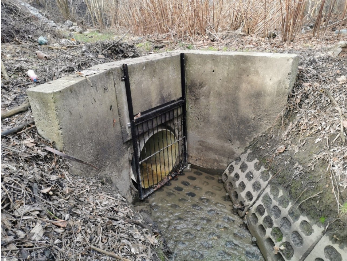
Krata na Potoku Ligockim przy ul. Pocztovej
