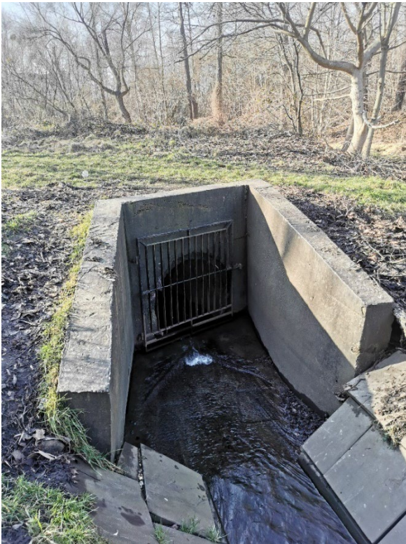
Krata na Potoku Szobiszowickim przy ul. Orląt Śląskich
