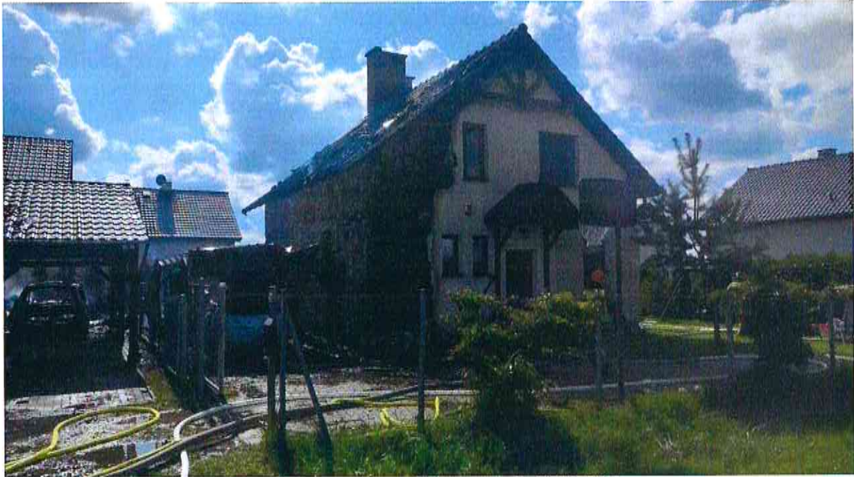
Fotografia 9 Pożar wiat w Sośnicowicach, 03.09.2023 r.
