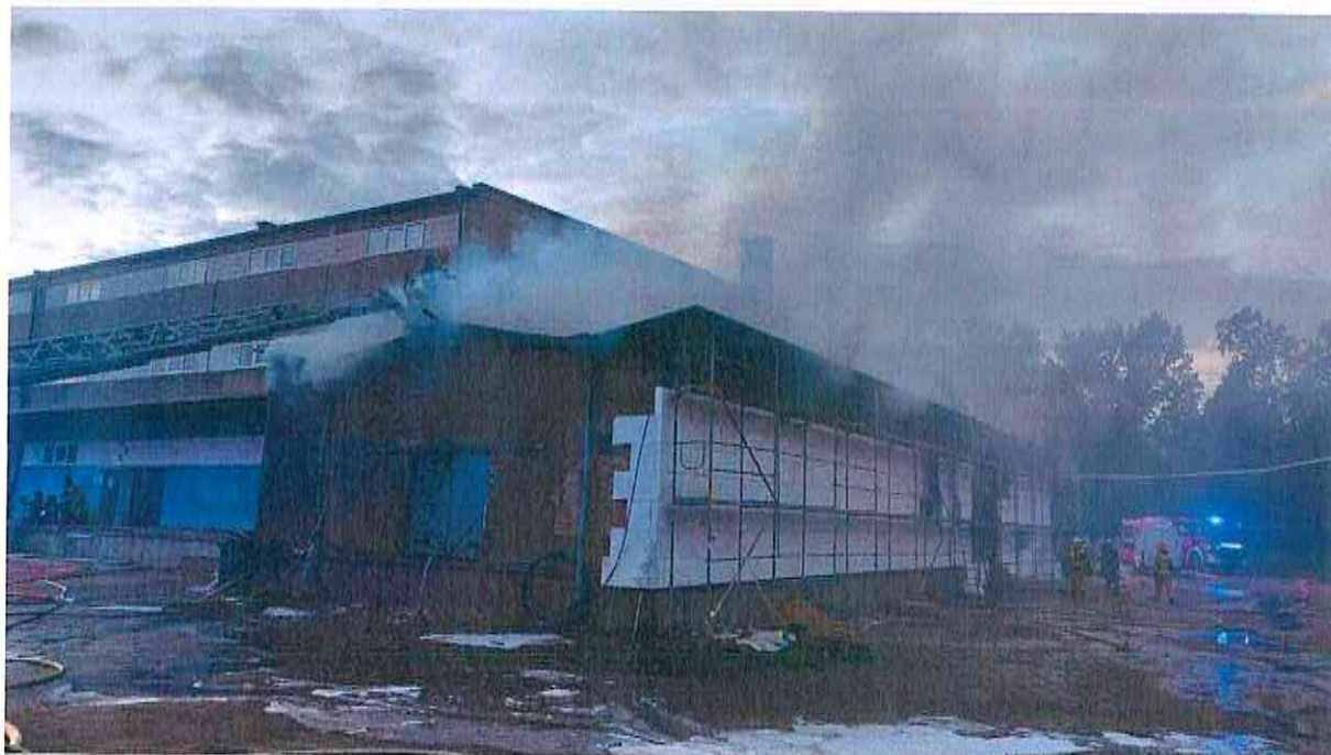
Fotografia 10 Pożar hali magazynowej, Gliwice ul. Portowa 10, 13.10.2023
